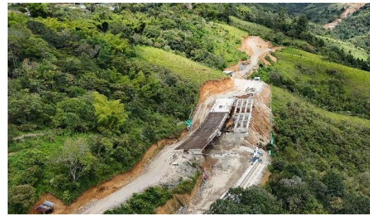
UF2- Puentes Piendamó, K 23+870 Izq. - K 23+340 Der.
