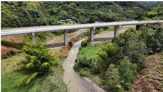
UF2 - Puente Bermejil, Piendamó, K 34+093 – K 34+249
