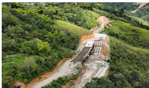
UF2- Puentes Piendamó, K 23+870 Izq. - K 23+340 Der.
