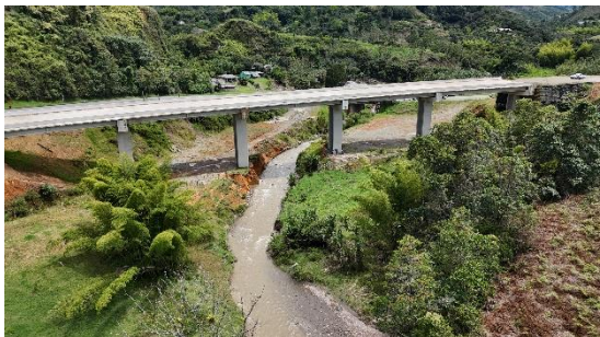
UF2 - Puente Bermejil, Piendamó, K 34+093 – K 34+249
