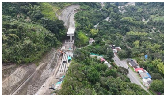
UF3- Puente 47+400, Caldon
