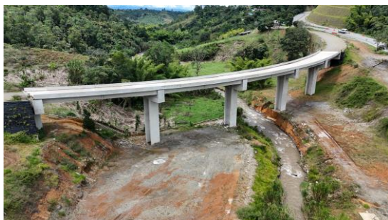
UF2 - Puente Bermejil, Piendamó, K 34+093 – K 34+249
