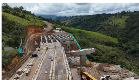
UF2- Puentes Piendamó, K 23+870 Izq. - K 23+340 Der.
