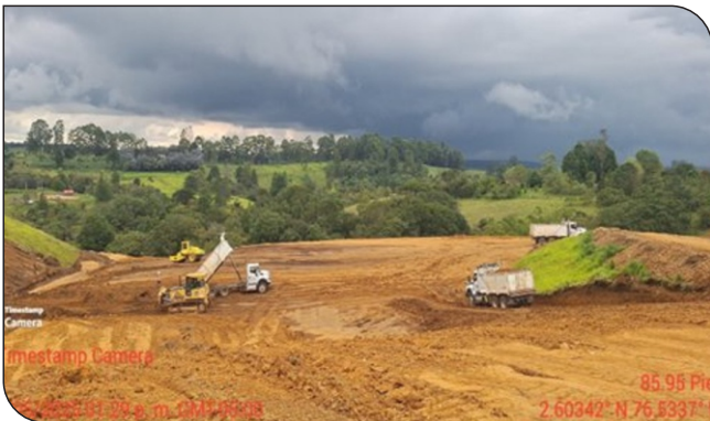
Programa de Manejo Ambiental para Sobrantes de Excavación, Adecuación y Conformación de Sitios de Depósito
