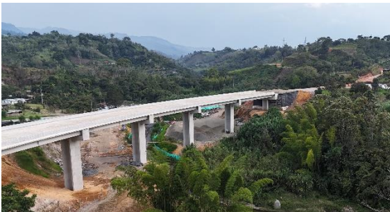
UF2 - Puente Bermejil, Piendamó - Tunía K 34+093 – K 34+249
