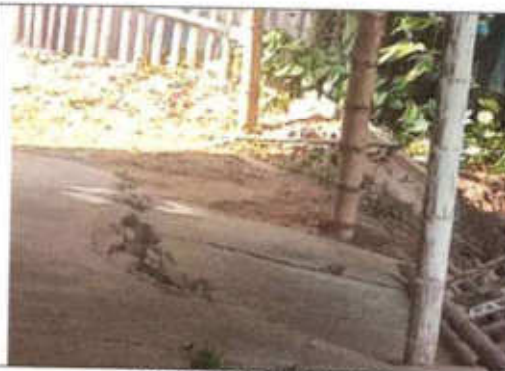
M18 POZO SÉPTICO
